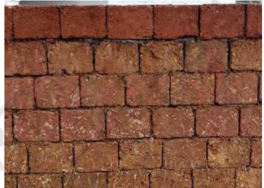
चित्र 11.7— ईंट बनाने के लिए लेटराइट का उपयोग
